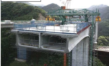
施工状況写真
