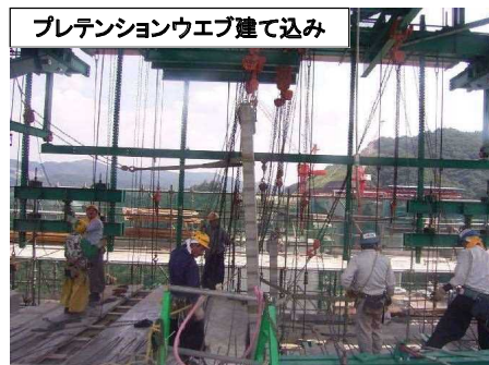
プレテンションウェブ設置完了
