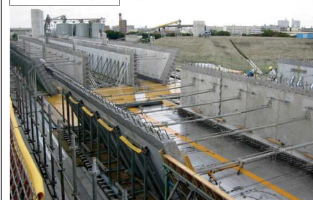
施工状況写真
