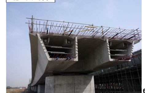
施工状況写真
