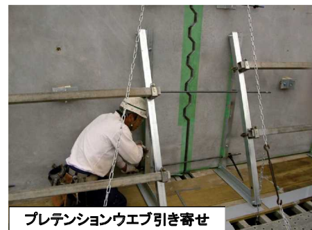
固定支保工架設のイメージ
