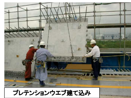
プレテンションウェブ設置完了
