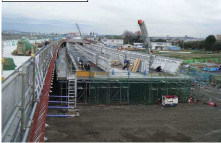
施工状況写真
